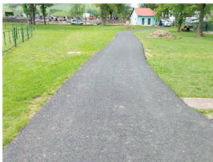
Rekonštrukcia prízjazdovej cesty v areáli futbalového ihriska.
