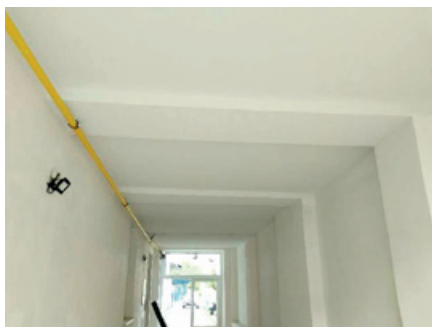
Zateplenie stropu priechodu v budove Pienap-u.
