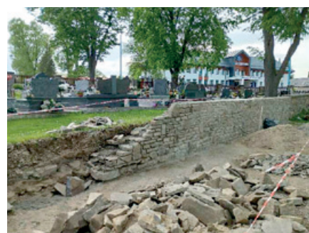
Začatie prác na oprave plota mestského cintorína.
