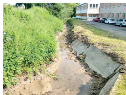
Čistenie potoka od nánosov za areálom základnej školy.
