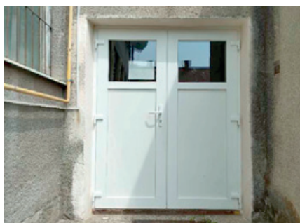
Výmena vchodových dverí v budove Domu služieb.
