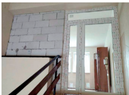
Výmena dverí v kultúrnom dome na schodišti pri vstupe do knižnice, domurovania murovanej priečky a usadenia nových dverí.
