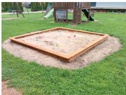
Výmena dreveného rámu pieskoviska na detskom ihrisku za kultúrnym domom.
