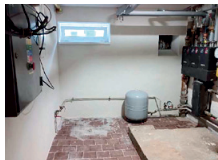
Rekonštrukcia stien kotolne na mestskom úrade.
