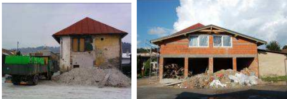
Výstavba sídla Pienap-u (február – máj 2010)
